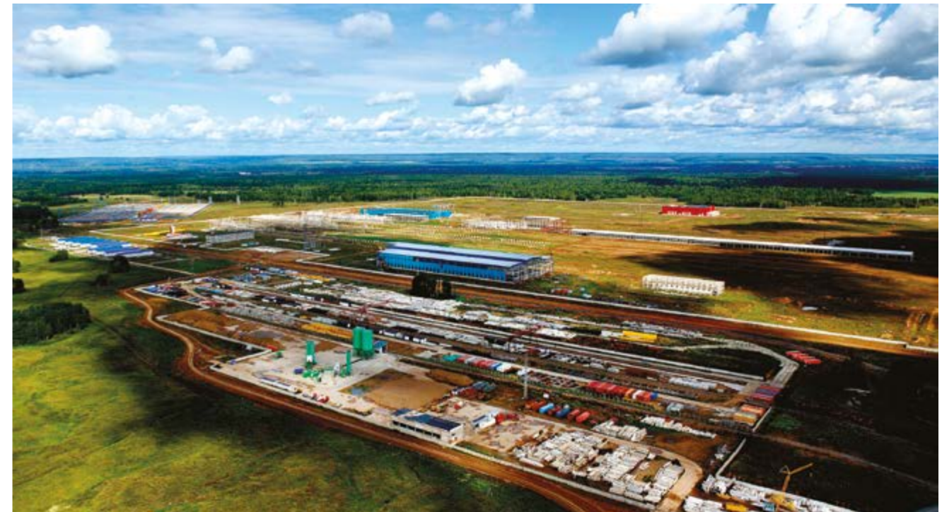
Тайшетский алюминиевый завод, ведется строительство
